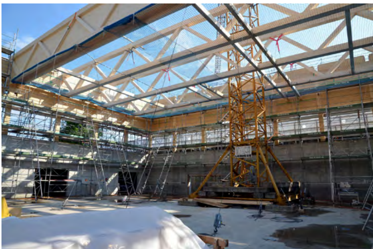
Rohbau der neuen Dreifachsporthalle im Juni 2014
