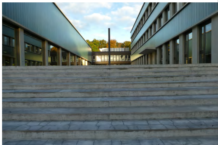
Die neue Dreifachsporthalle, das Hauptgebäude und das Institutsgebäude (v. l.)
