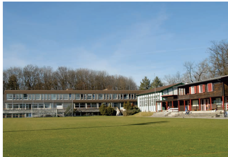
Blick vom Rasenplatz auf das Gebäude A, mit Turnhalle C und «Chalet» am Bildrand
